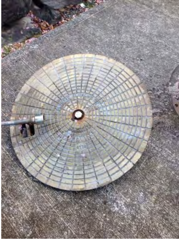
Wet well manhole lid
