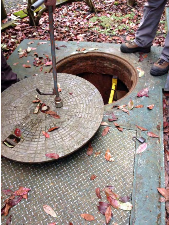
Wet well manhole lid
