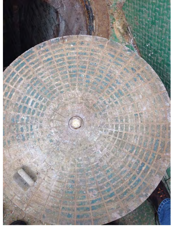
Wet well manhole lid
