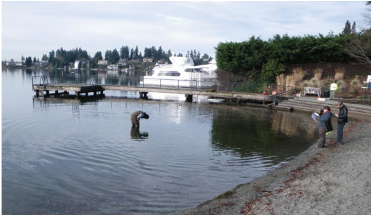
Работник коммунальной службы проверяет озёрную линию.
